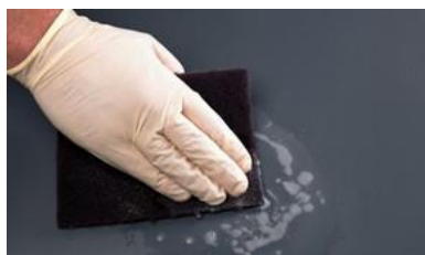
PVC come sottofondo: in caso di formazione di schiuma, il processo di pulizia può essere completato con un risciacquo.
